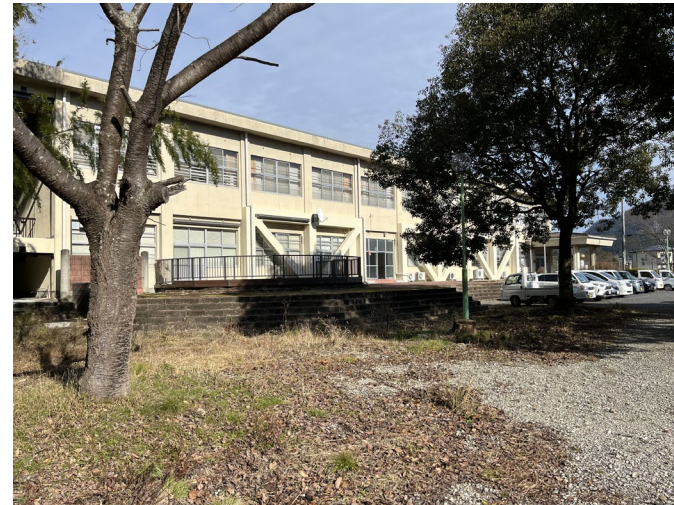
元高校の校舎が再利用された和東SWOの外観 (22年12月21日撮影)
