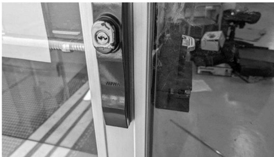
図7 正面から見た様子
