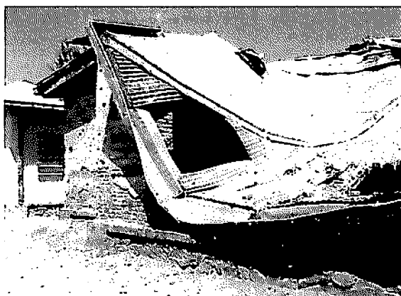
壊れた生物実験室
