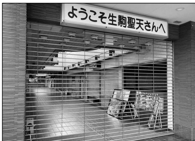
図2 設置されているグリルシャッター
